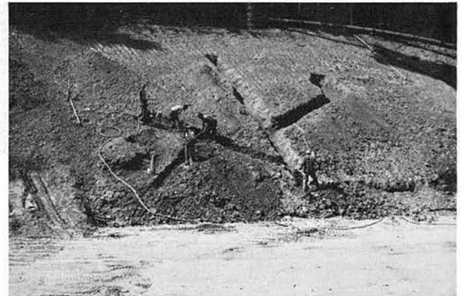
Abb. 1: Selbst im Zweifelsfalle ist das Erstellen von Sickergräben und Sickerpackungen zur Ableitung der Wasseraustritte empfehlenswert. An Berghängen muß das Wasser vorsorglich schon möglichst hoch oben abgefaßt werden.
