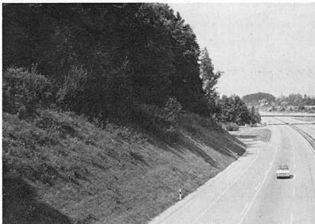
Abb. 9: Der aufwachsende Waldmantel schafft den erwünschten Übergang von der Böschung zum Hochwald. Genügendes Lichtraumprofil durch gemähte Böschung.
