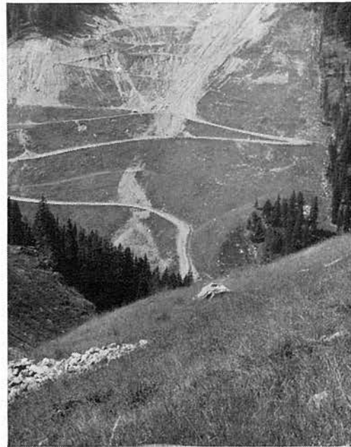
Abb. 6: Extremes Baugelände nahe der alpinen Waldgrenze, 5 Jahre nach Begrünung. Vom Gegenhang wurde das Material für die Schüttung des Staudammes entnommen. Die Begrünungsflächen waren vollkommen steril und mutterbodenlos. Die heutigen Kahlstellen beruhen auf der Wahl zu steiler Böschungsneigungswinkel im oberen Hangabschnitt. Jedes Jahr geht mindestens einmal eine Lawine über den Hang hinweg, die selten vor dem Juli abschmilzt.
