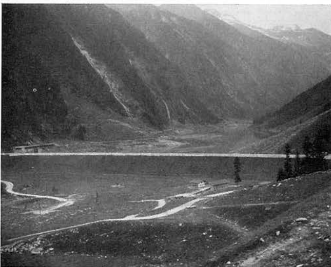
Abb. 3: Durch SCHIECHTELN® reaktivierter Staudamm und Baugelände in den Zillertaler Alpen. Der Staudamm wird als Mähwiese genutzt, das Entnahmegelände für die Dammschüttung als Weide. Die ehemals extensiv bewirtschaftete Alpe wurde dadurch intensiviert. Die Größe der neu errichteten Alpegebäude weist auf den Futterertrag hin.
