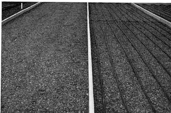
Abb. 1 Dränschicht aus Kies mit Heizrohren (rechts)
