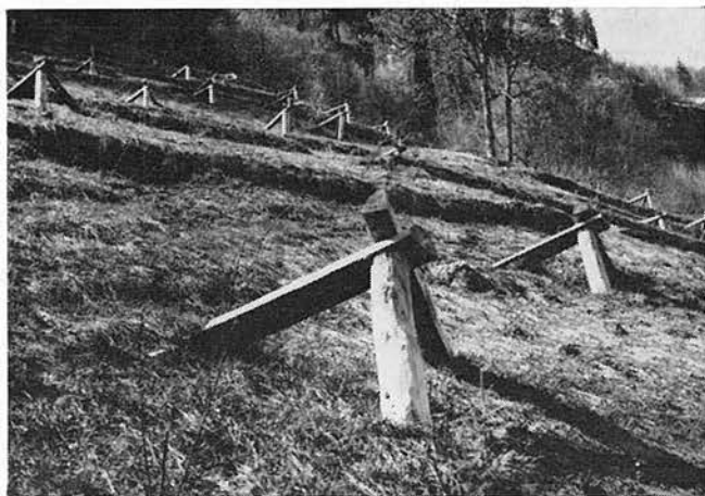
Bild 7: Abseits der Piste. Verbauung gegen Grundlawinen und Kriechschnee beispielsweise durch die Kombination von Holzdreibeinen, Quertrossierung und Aufforstung der ganzen Fläche
