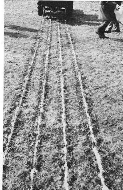
Bild 4 Permadrain Tragschichtbelüfter im Einsatz.
