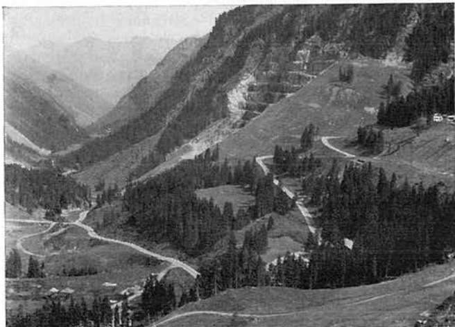
Abb. 5: Baugelände unterhalb eines Staudammes in den Otztaler Alpen bei ca. 1700 m Seehöhe. Alle Begrünungen wurden mit SCHIECHTELN® ohne Mutterboden durchgeführt.
