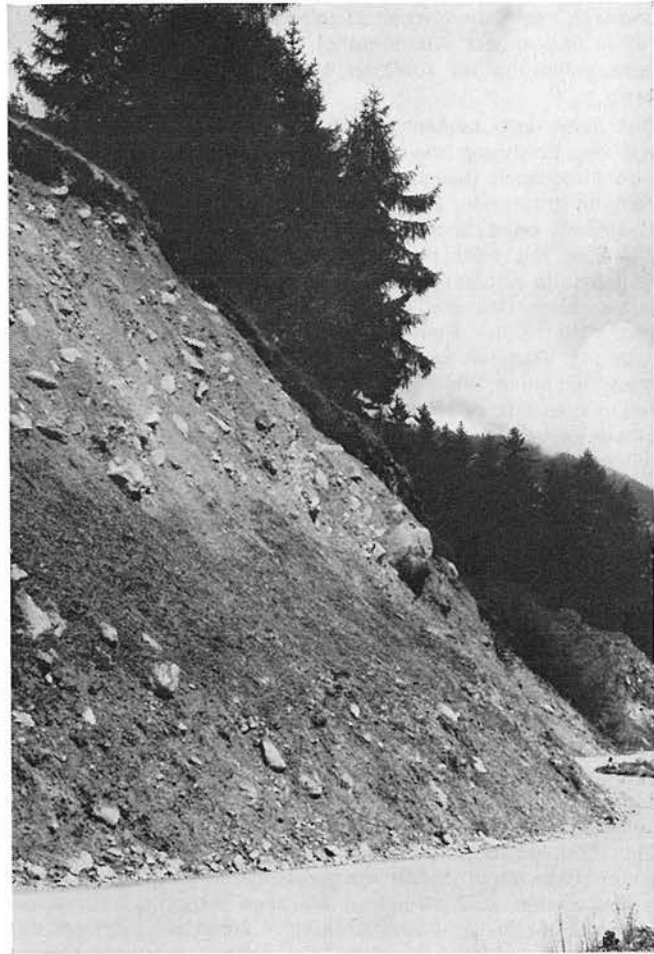
Abb. 12: Die auf dieser Steilböschung ausgeführte maschinelle Strohabdeckung zeigt den Nachteil zu kurzer Strohhalme, die kein zusammenhängendes Geflecht bilden. Nach dem ersten heftigen Gewitter wurde die Saat samt dem Stroh nach unten geschwemmt; Mißerfolg. — Besonders auf extremen Standorten ist der Saatetermin, die Art und Ausführung einer geeigneten Mulchschicht für den Erfolg einer Begrünungssaat ausschlaggebend. Die Mulchschicht soll Erosionseinwirkungen weitgehend widerstehen können und die mikroklimatischen Bedingungen zur anfänglichen Förderung der Pflanzenentwicklung verbessern. Deshalb ist besonders auf Steilböschungen in Gebirgsregionen die von Hand mit rel. langhalmigem Stroh ausgeführte Bitumen-Strohdeckschicht (nach Schiechtel-Verfahren) dem maschinellen Strohmulch-Verfahren überlegen und sicherer.
